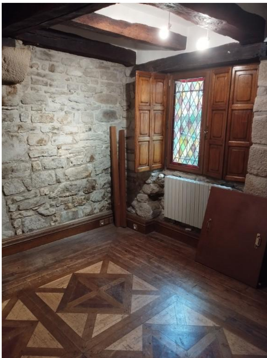
Détail des volets en bois au rez-de-chaussée
