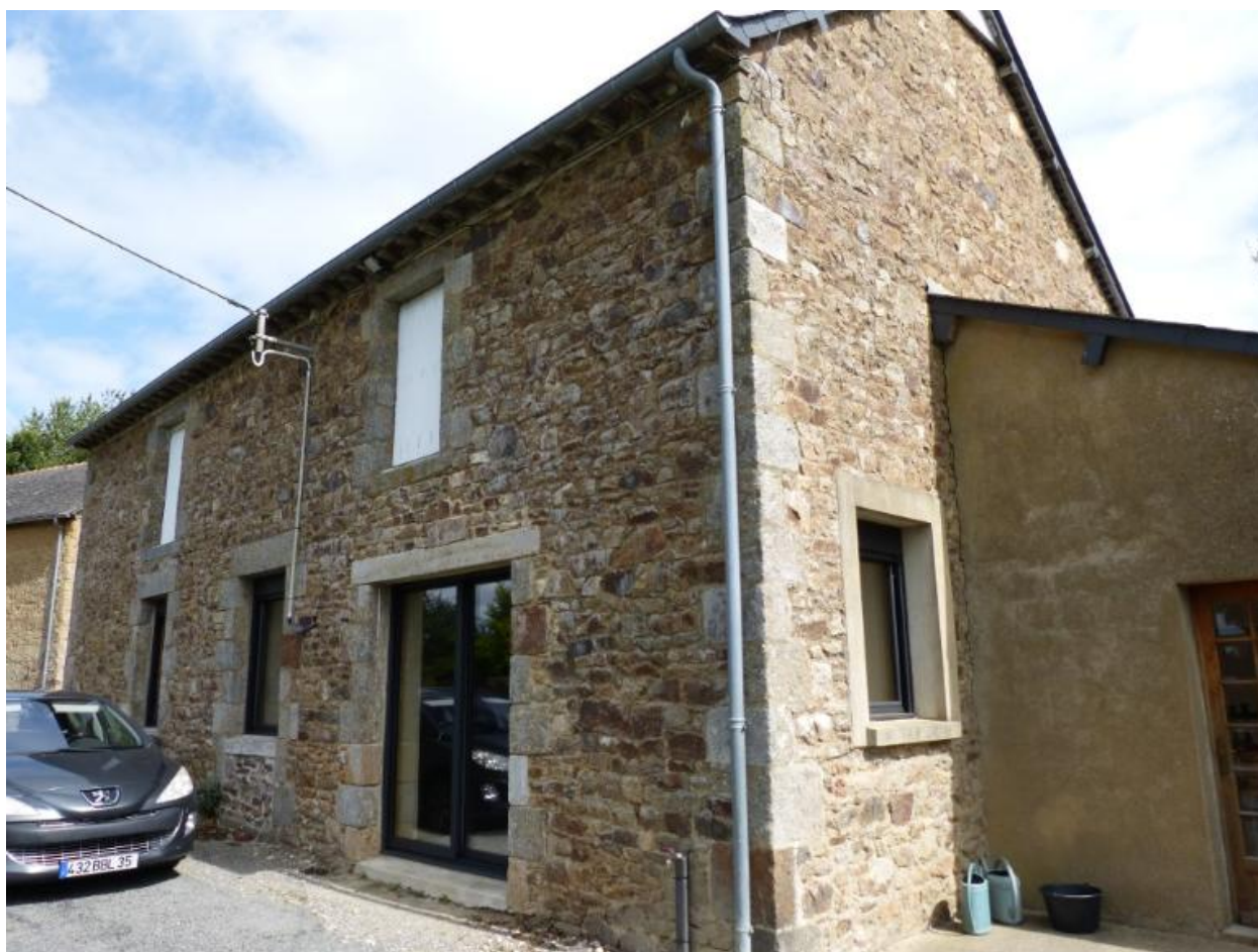
Vue générale sud est, La Chambrette (Hédé-Bazouges)
