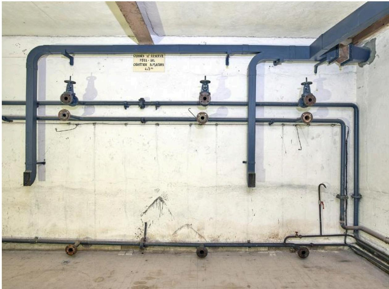
Vue du deuxième étage : "réserve à gas-oil" : 24 m<sup>3</sup> (fonction de 1966). Sur le panneau, on peut lire "Caisses de réserve / Fuel-oil Chantier S[ous]-marins / 4 x 3 m<sup>3</sup>"
