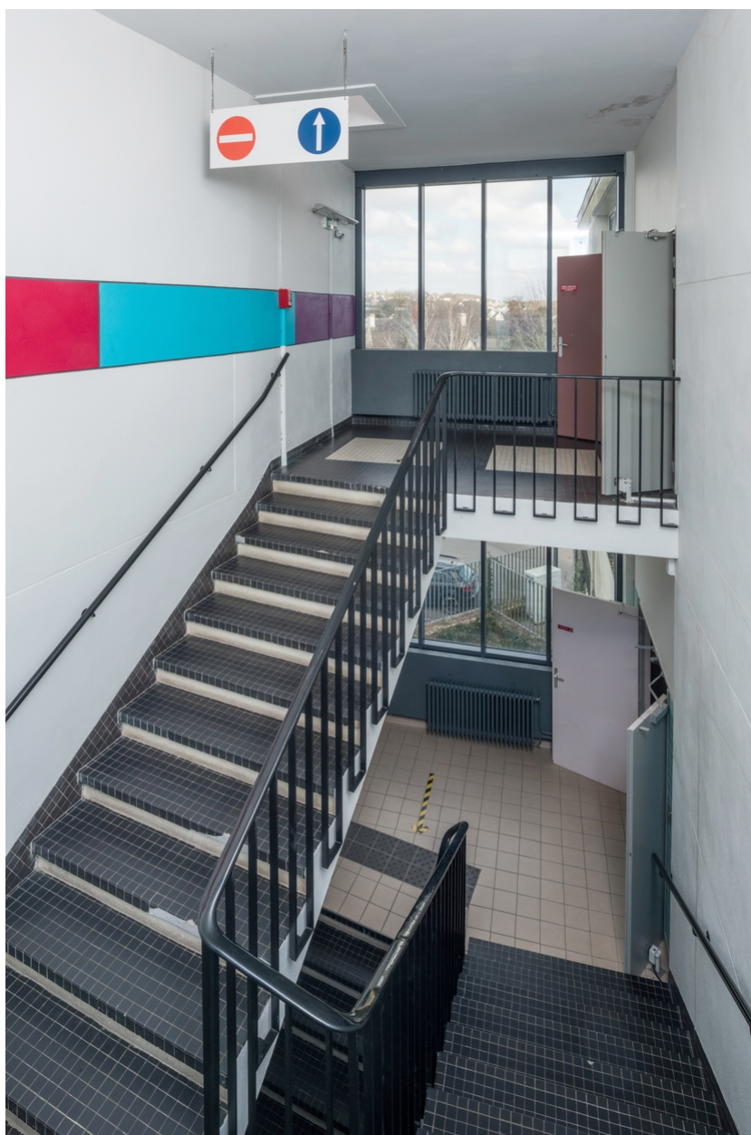
Cage d'escalier nord-est de l'externat. Raymond Lopez, architecte, 1958.
