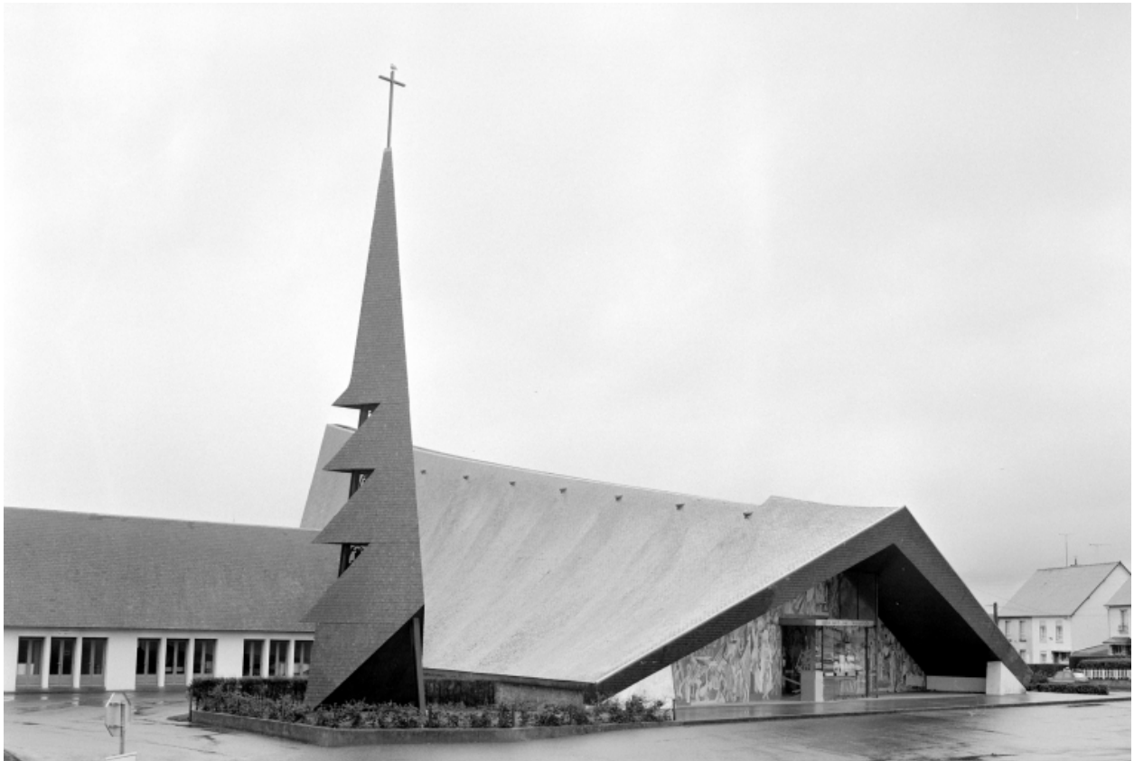
Elévation Ouest : vue générale
