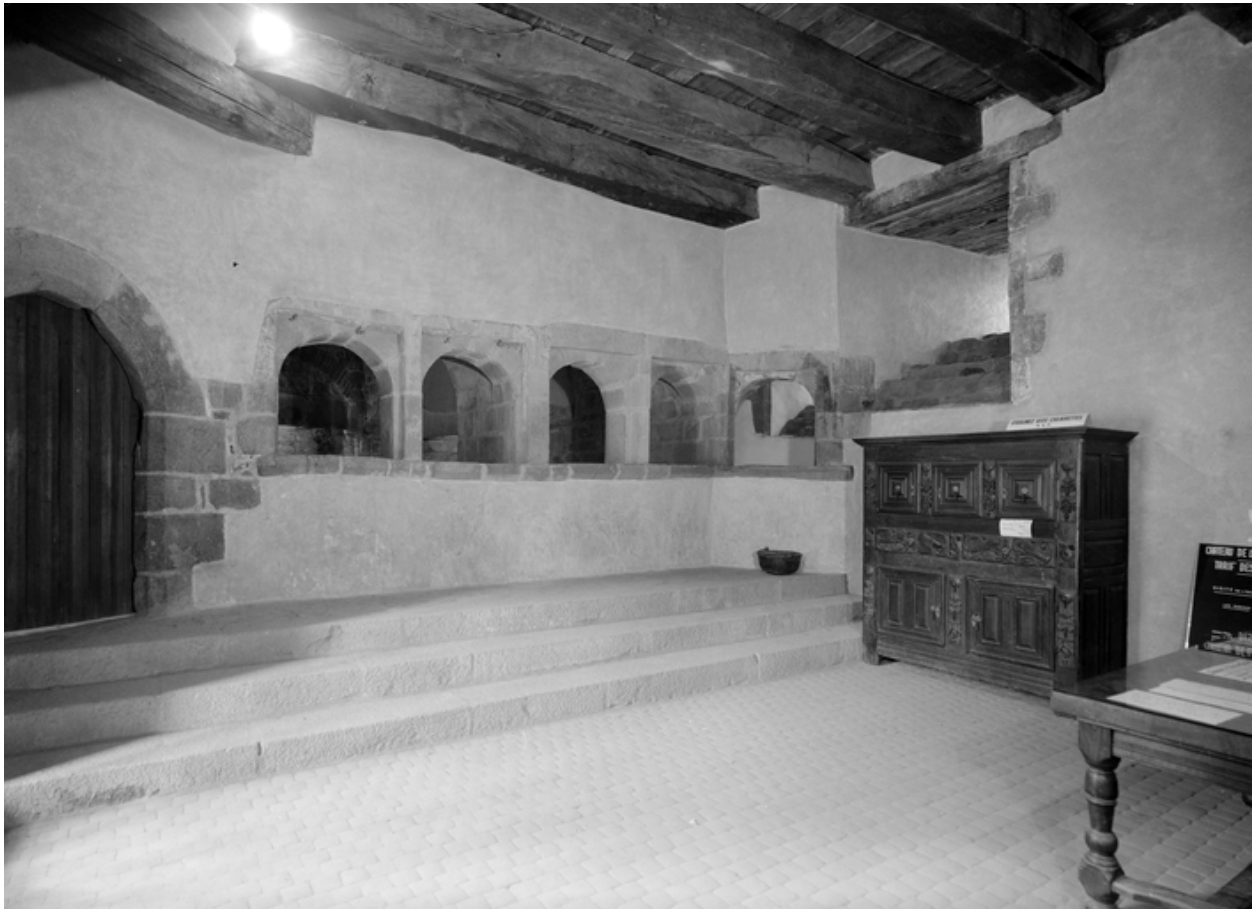
Vue de l'ensemble de cinq passe-plats depuis la salle basse (état en 1974). A gauche, la porte de la tour abritant l'escalier et la porte de cuisine
