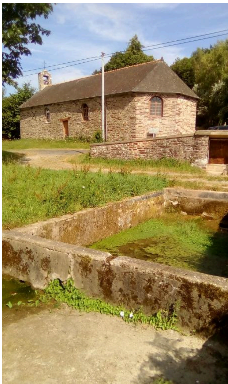
Vue de la chapelle prise du sud-est, au premier plan le lavoire et la fontaine
