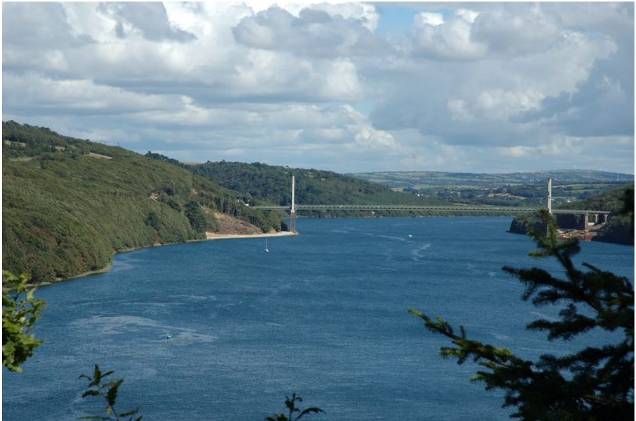
L'Aulne maritime : vue du pont de Térénez (le premier pont de 1925-1926 détruit en 1944 est reconstruit entre 1945 et 1951)
