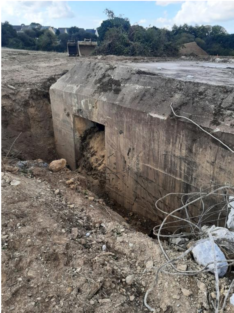
Vue de la déconstruction : entrée est (25 septembre 2022)
