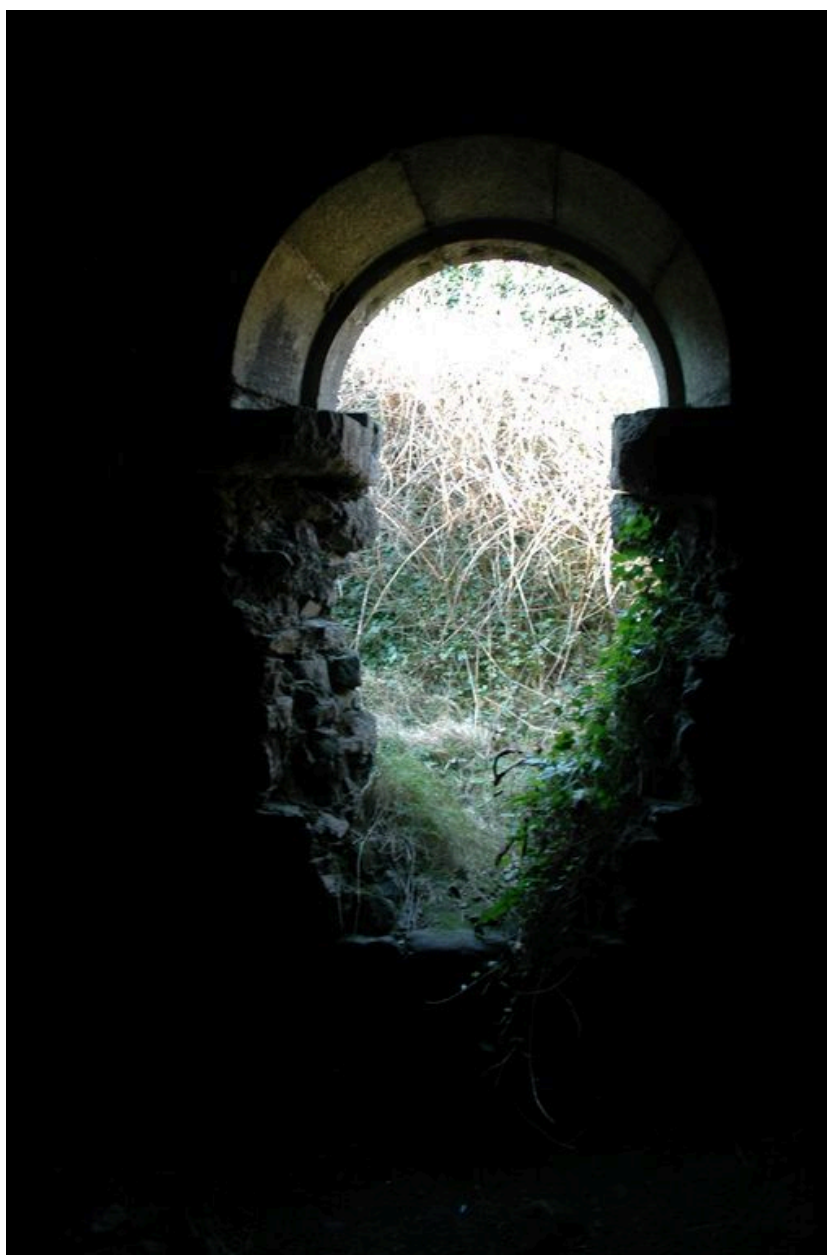
Vue intérieure : baie haute dégradée (état en 2006)
