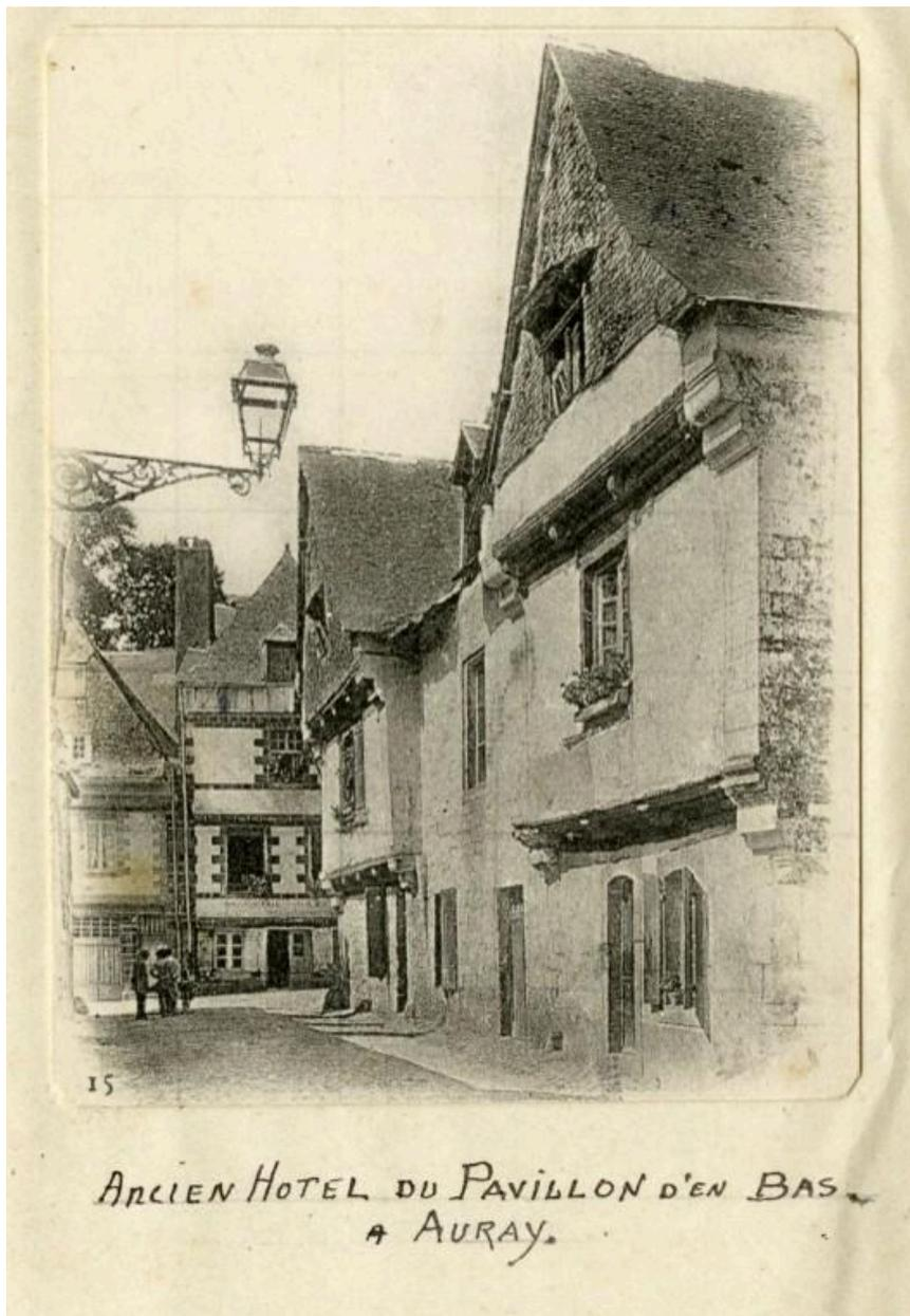
Sur cette photographie d'avant 1925, la façade centrale est déjà remontée en maçonnerie.
