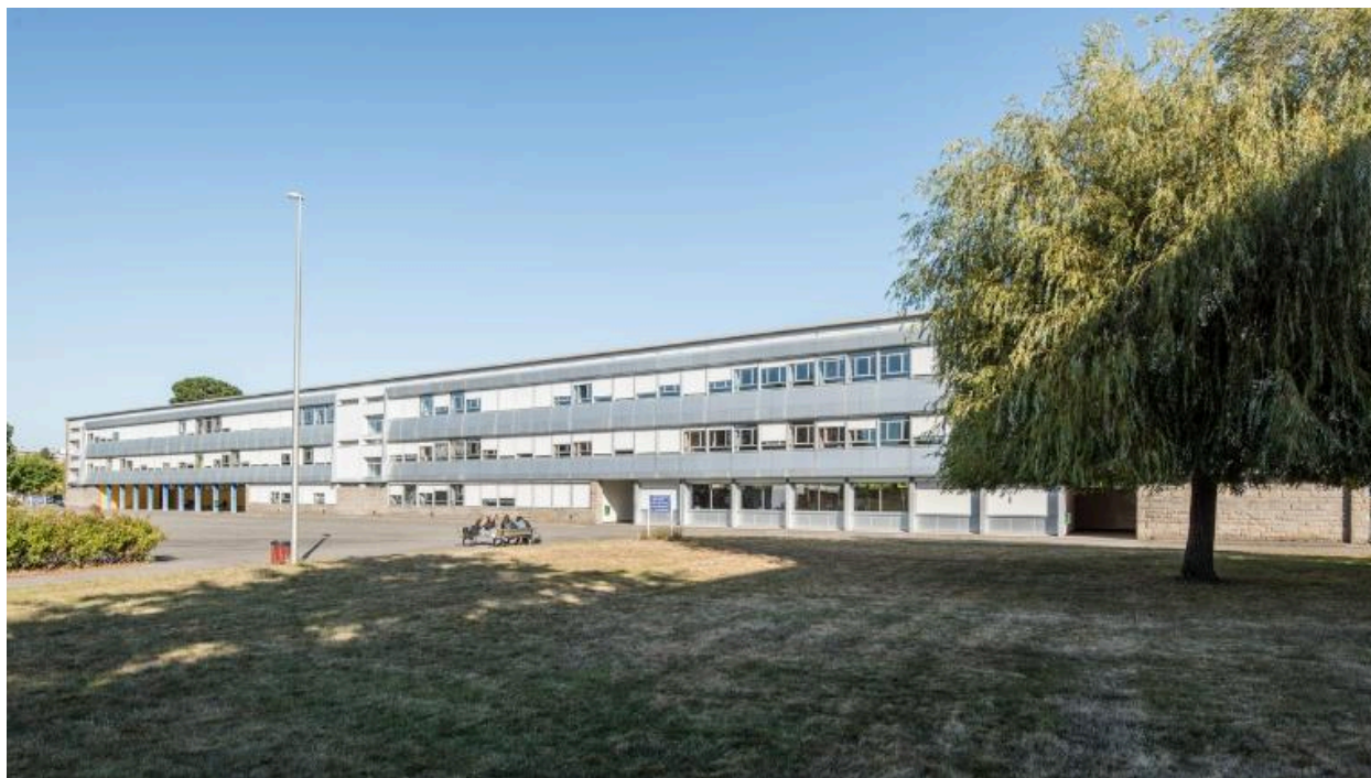
Bâtiment D, externat : façade sud. Louis Arretche et Jean Monge, architectes, plans 1959.
