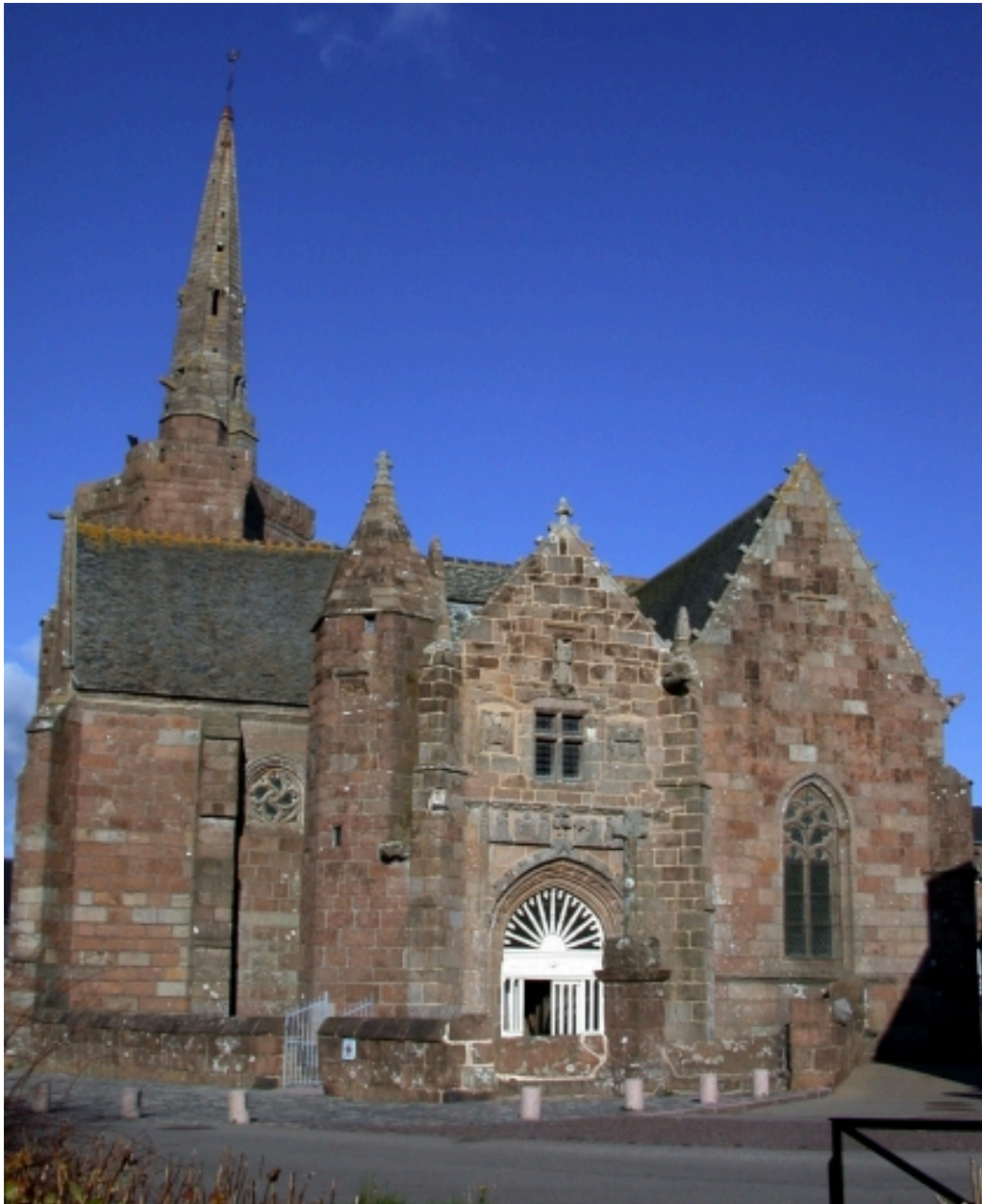
Vue générale (élévation sud)
