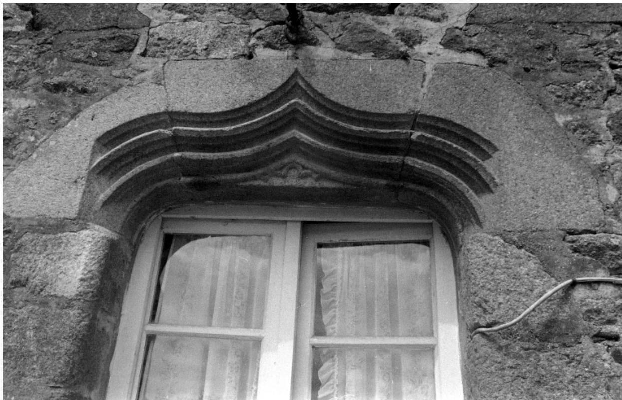
Détail de la fenêtre à accolade
