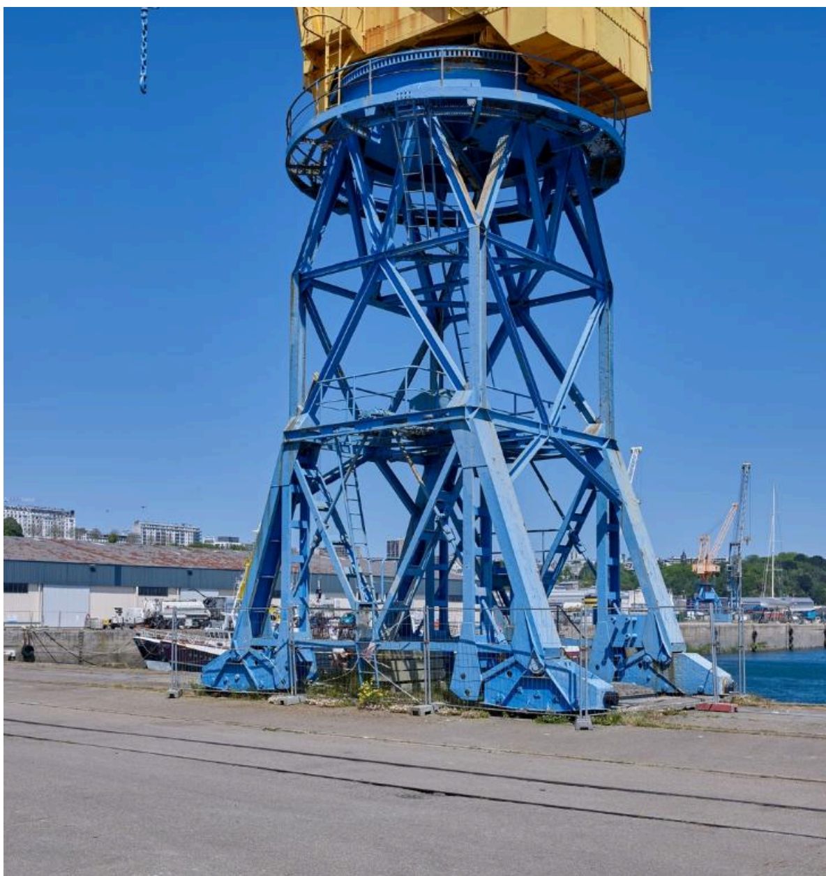
Grue Paindavoine n°4
