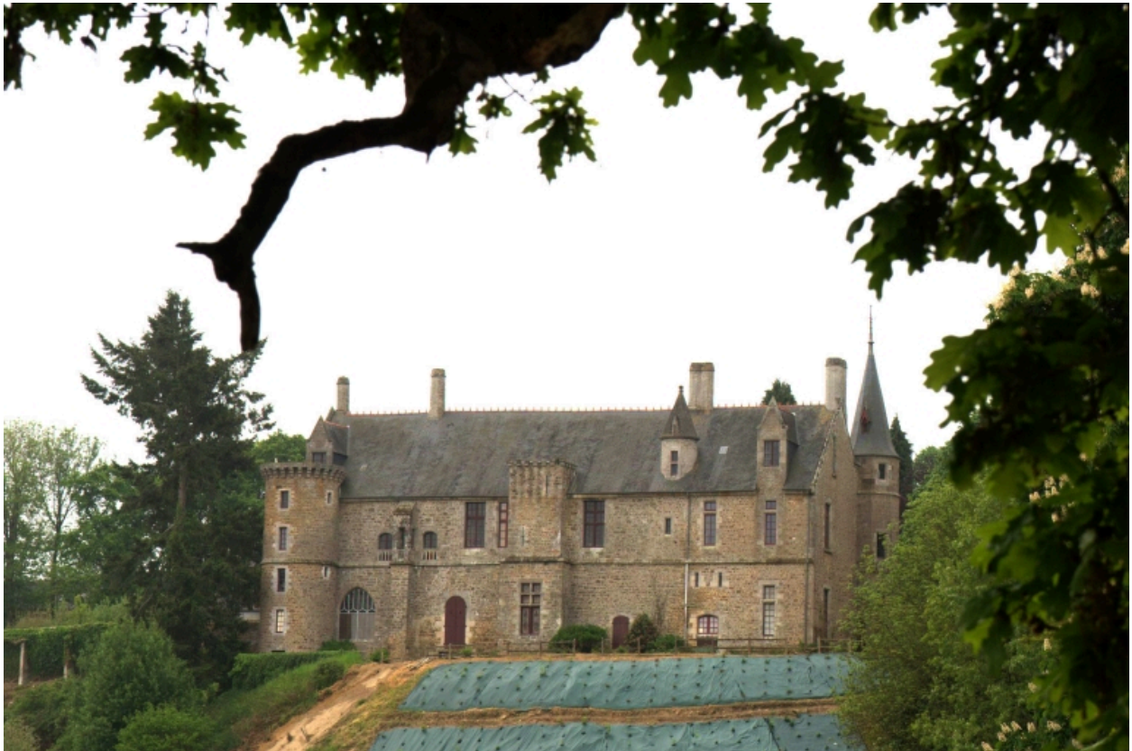
Château, vue générale de la façade donnant sur la Rance
