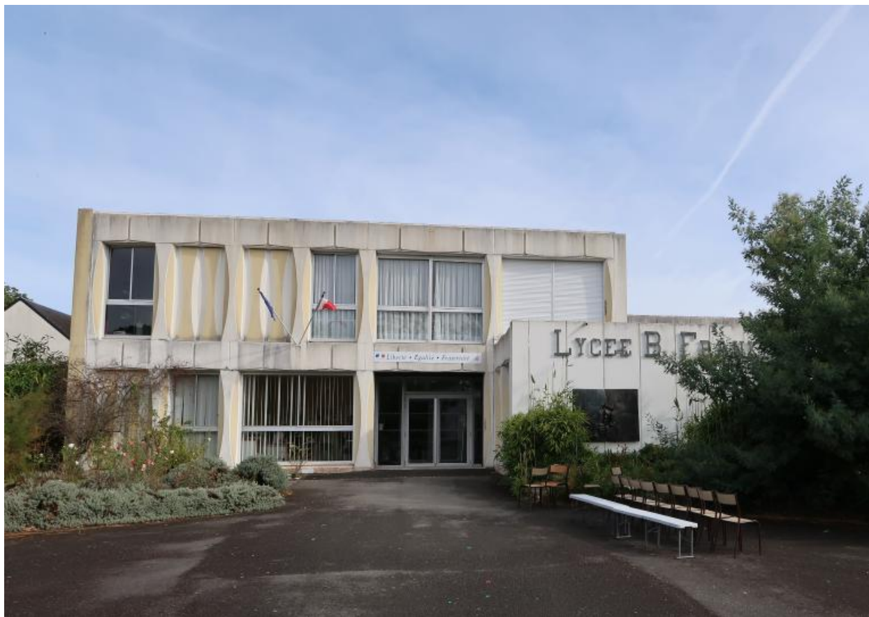
L'entrée du lycée (bâtiment administratif. Sur le mur, à droite, le bas-relief en bronze de Martine Kerbaol, dans son contexte en 2019.
