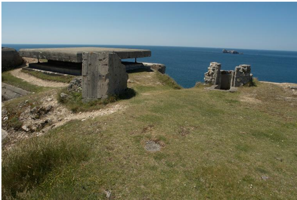
Vue de situation du bunker - poste de direction de tir de type M162a. A droite : petit observatoire ayant perdu sa couverture
