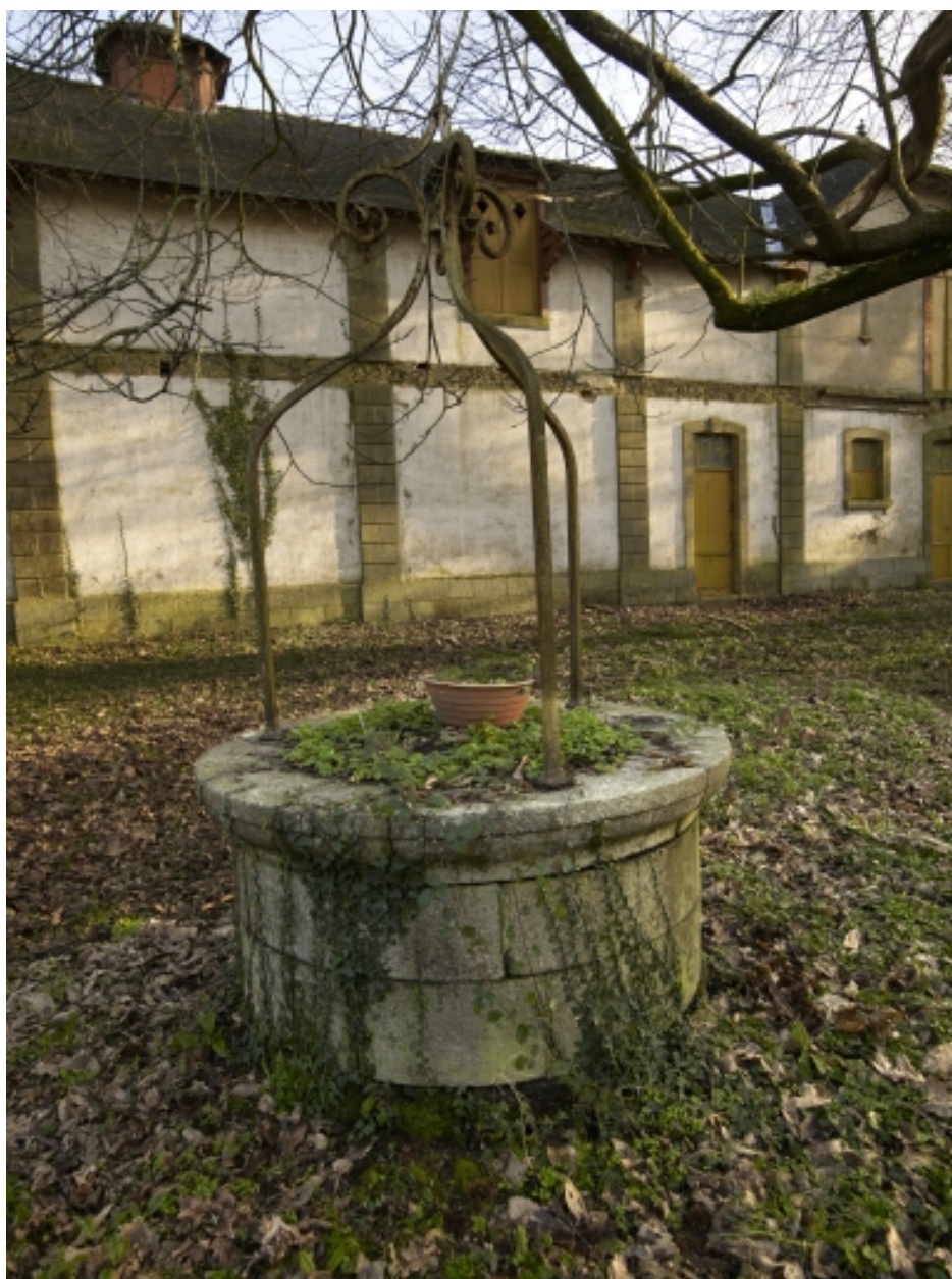
Cour de la ferme, puits
