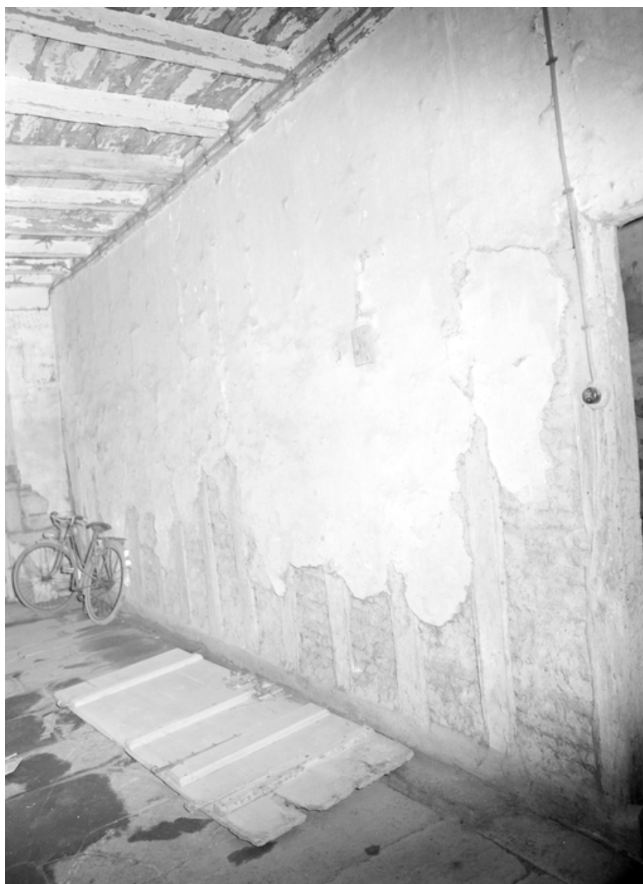
Intérieur, rez-de-chaussée : couloir de refend.
