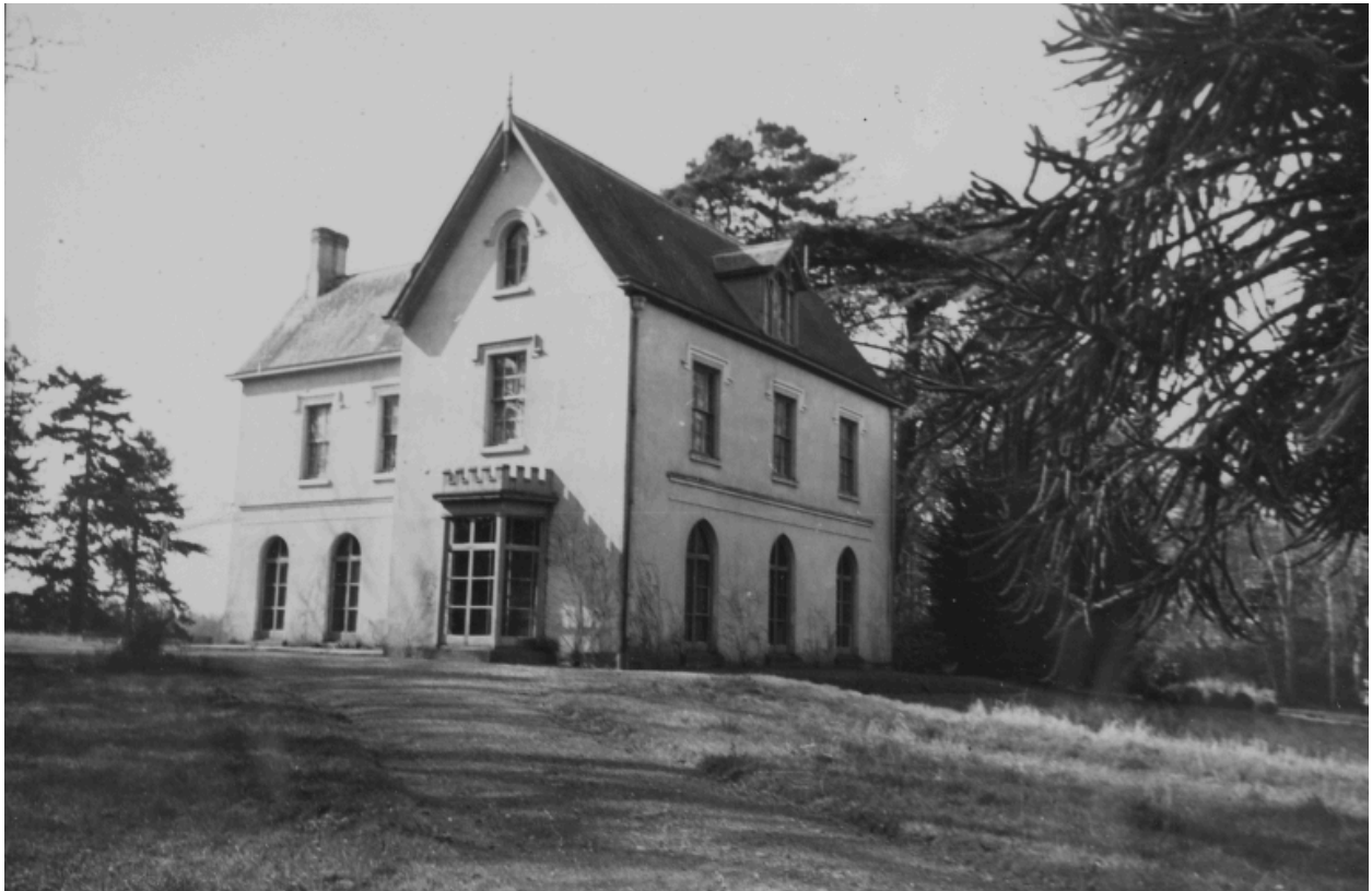
Etat avant transformation (état en 1973)
