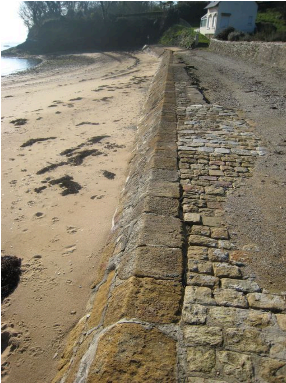
Partie du débarcadère au fond du port
