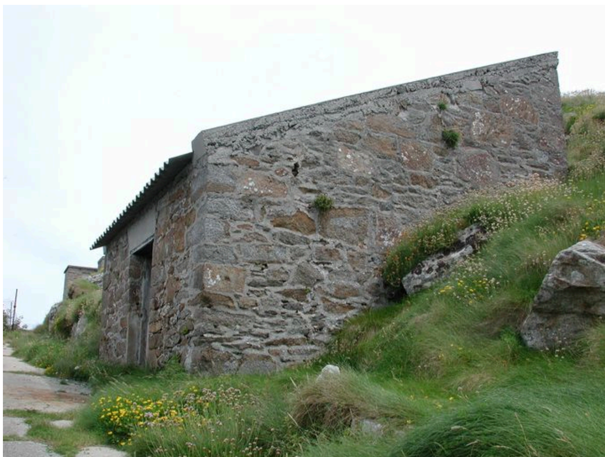
Vue du corps de garde de la pointe de Kermorvan. L'édifice, fortement remanié conserve une cheminée et un four
