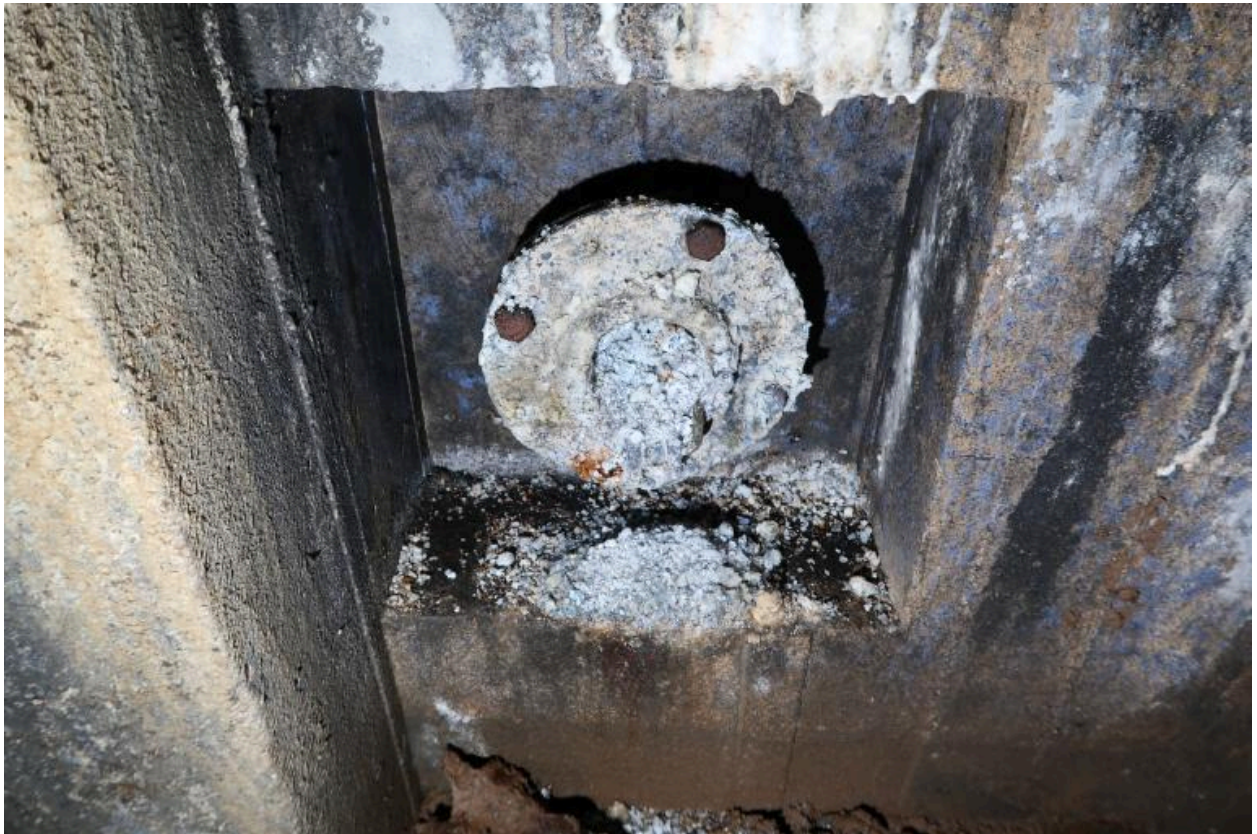
Vue du clapet/bouche de surpression de la pièce de vie - chambre de troupe
