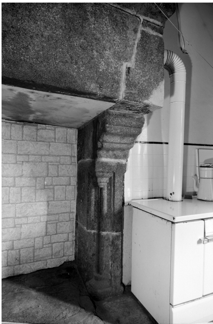
Détail du piédroit et console sud
