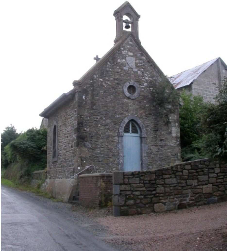
Vue de situation de la chapelle
