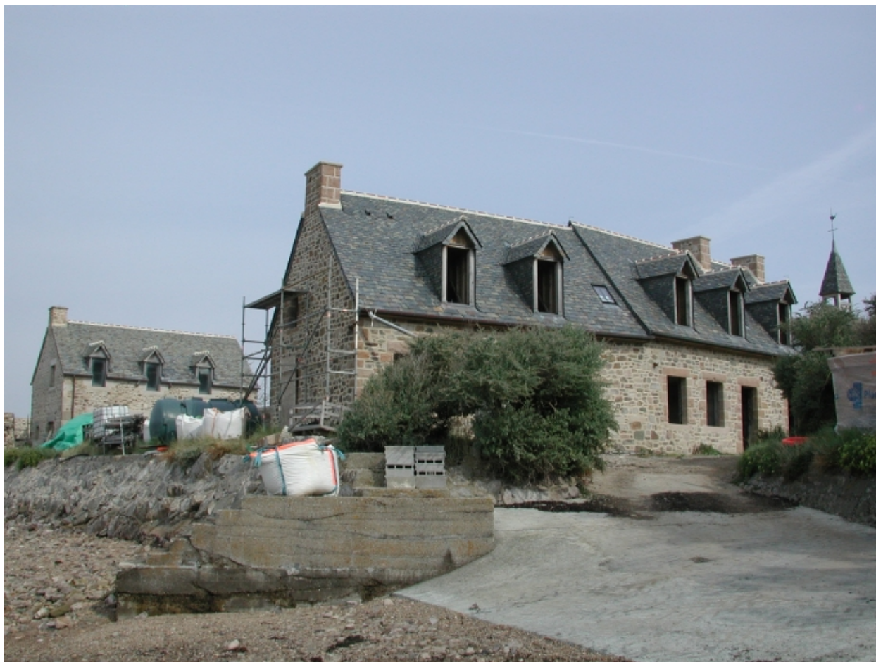
Vue des bâtiments de l'aile Sud et Nord
