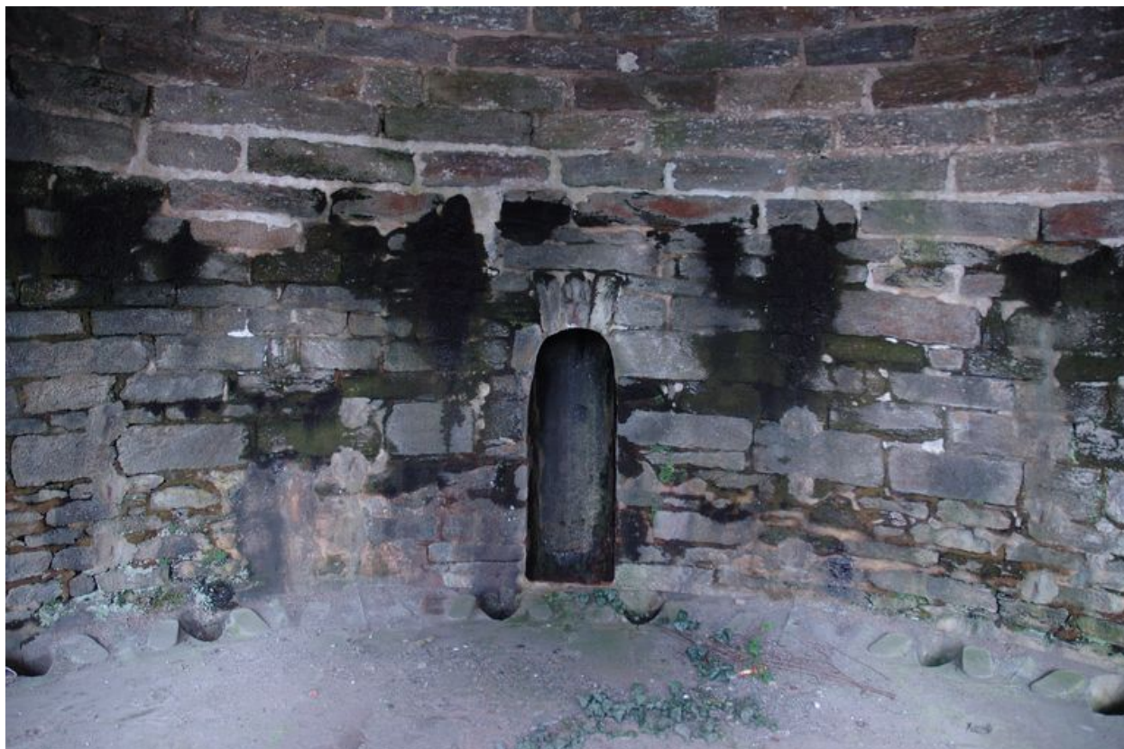
Vue intérieure des latrines collectives
