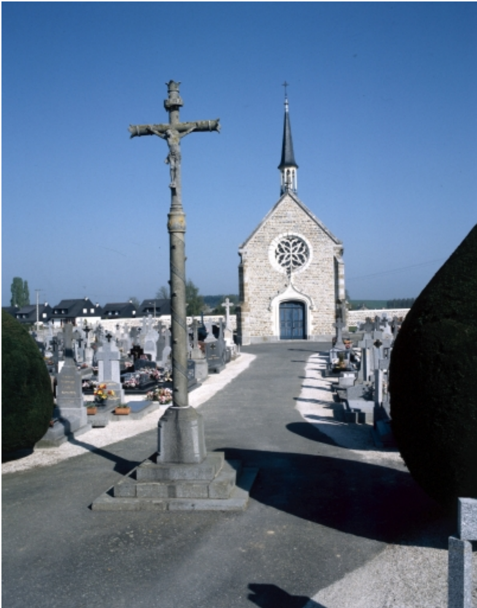
Elévation sud, vue générale.
