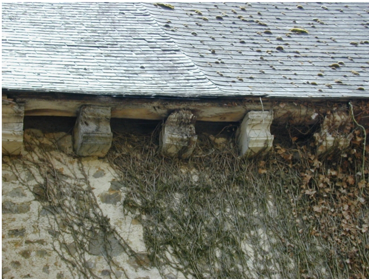
Détail des corbelets de l'écurie : façade postérieure
