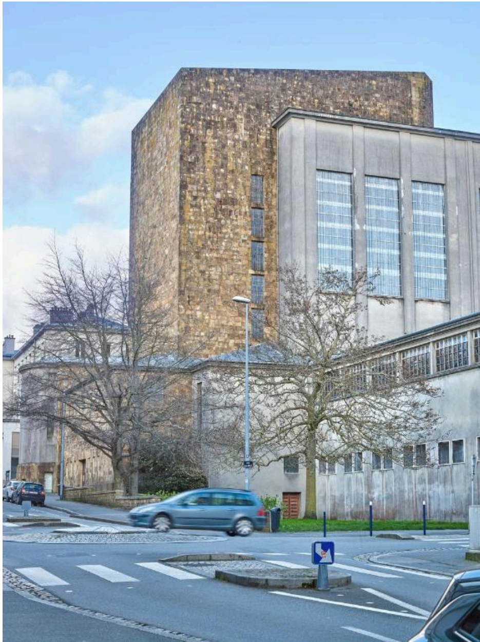
Eglise Saint-Louis, élévation est, matériaux différents (pierre de logonna, béton, verre), fonctions différentes (usage communautaire, fonction religieuse)
