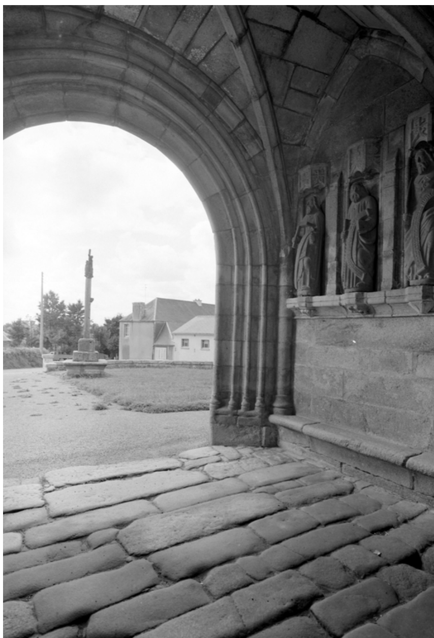
Vue intérieure de l'angle sud ouest du porche
