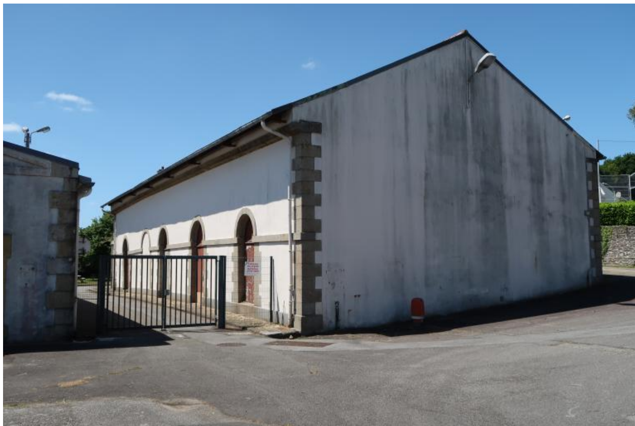
Vue de l'un des anciens bâtiments industriels (état en 2022)
