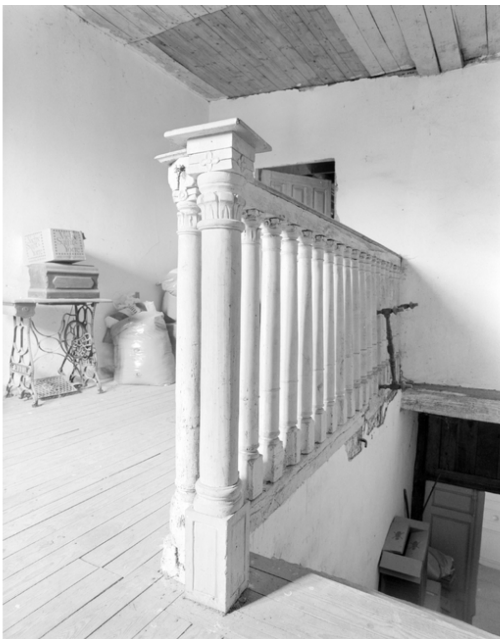
Vue de détail de la balustrade et du chapiteau, grenier.
