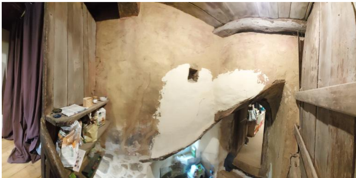
Cage d'escalier du manoir de Panduonec
