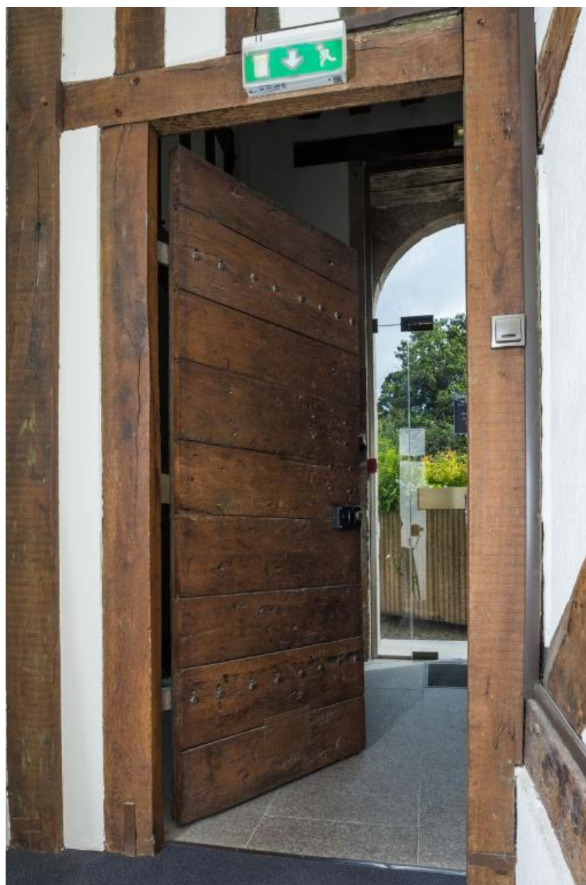
Intérieur, ancienne porte de la cage d'escalier
