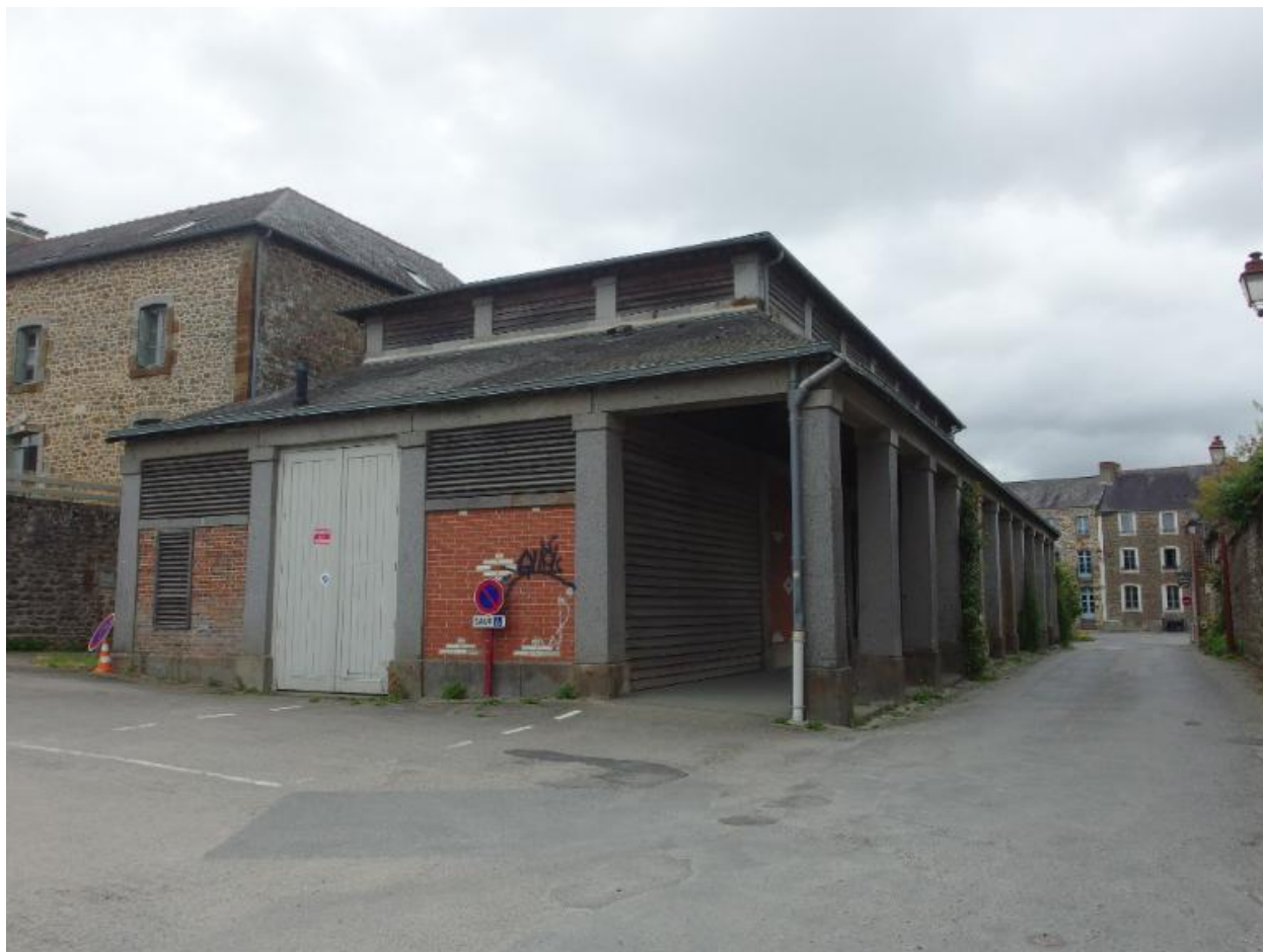
Vue sud ouest des anciennes halles
