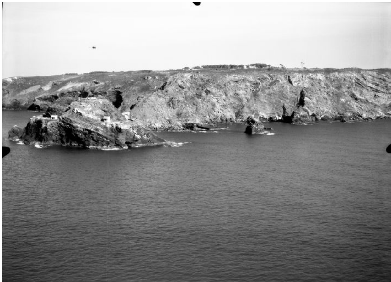
Vue aérienne de l'îlot fortifié des Capucins en 1971
