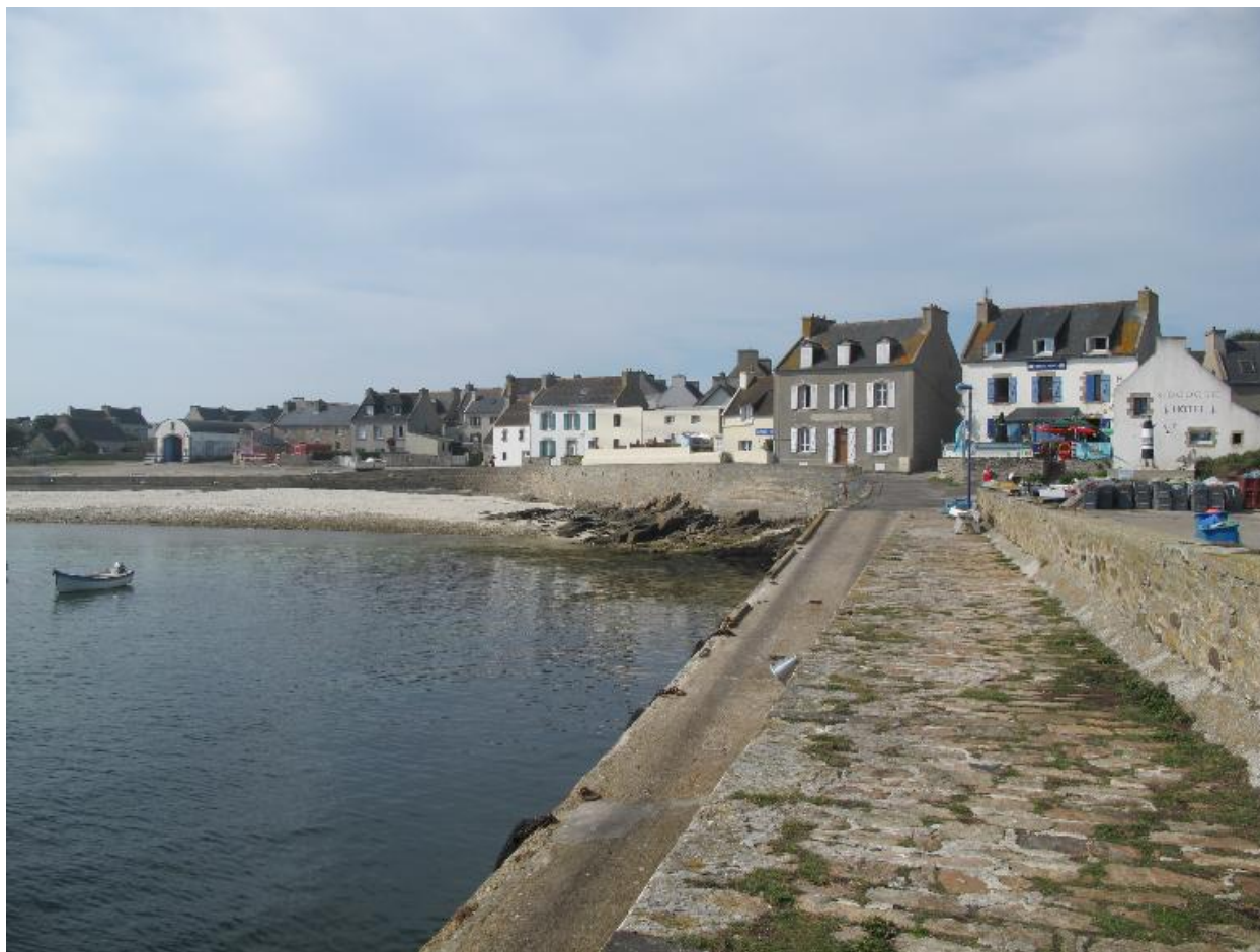
Le port de Molène, digue (1863)
