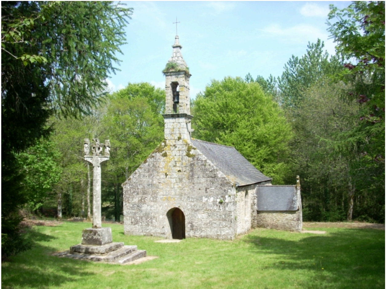
Plouyé, chapelle Saint-Mathurin : vue générale sud-ouest
