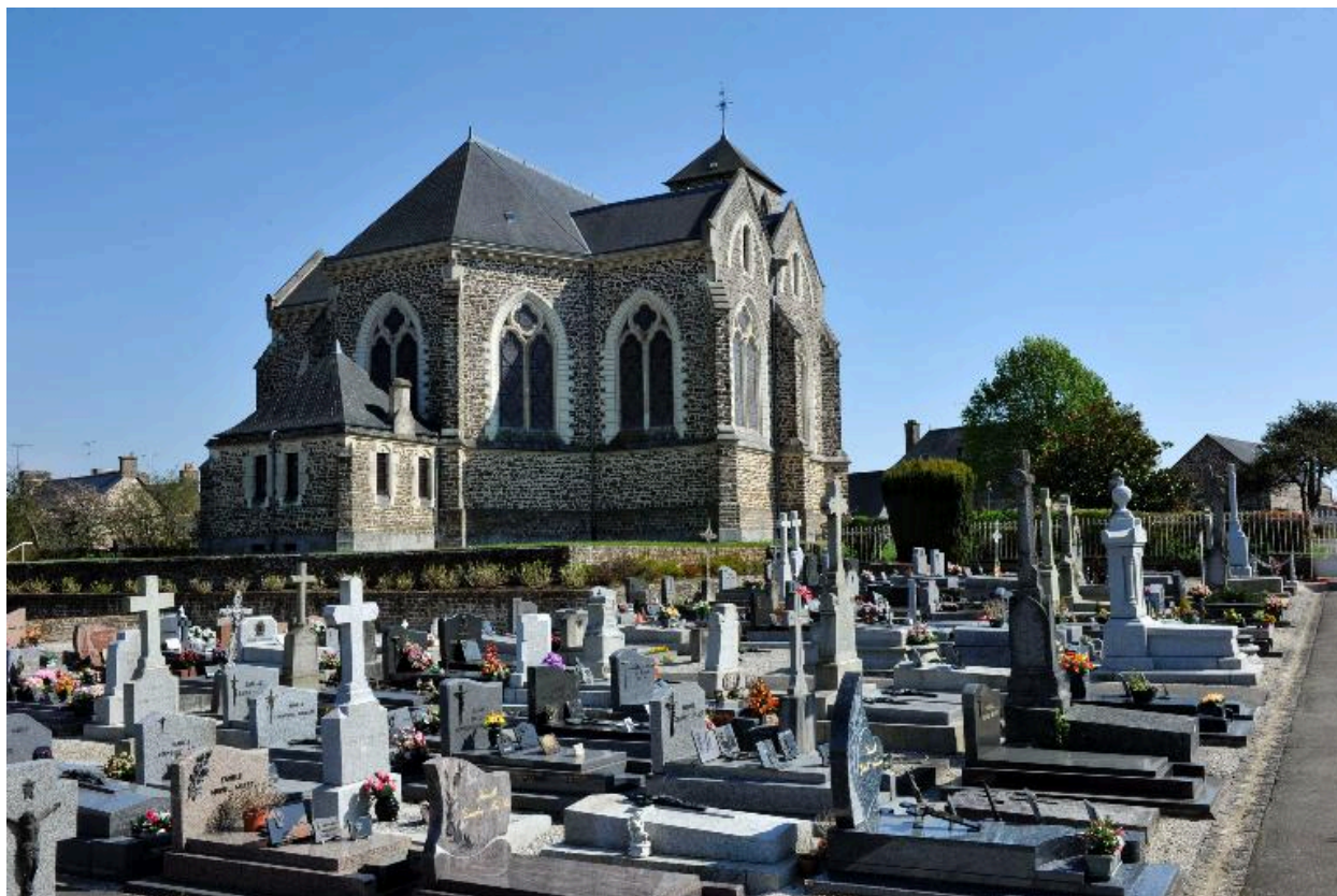
Vue générale : côté Nord-Ouest
