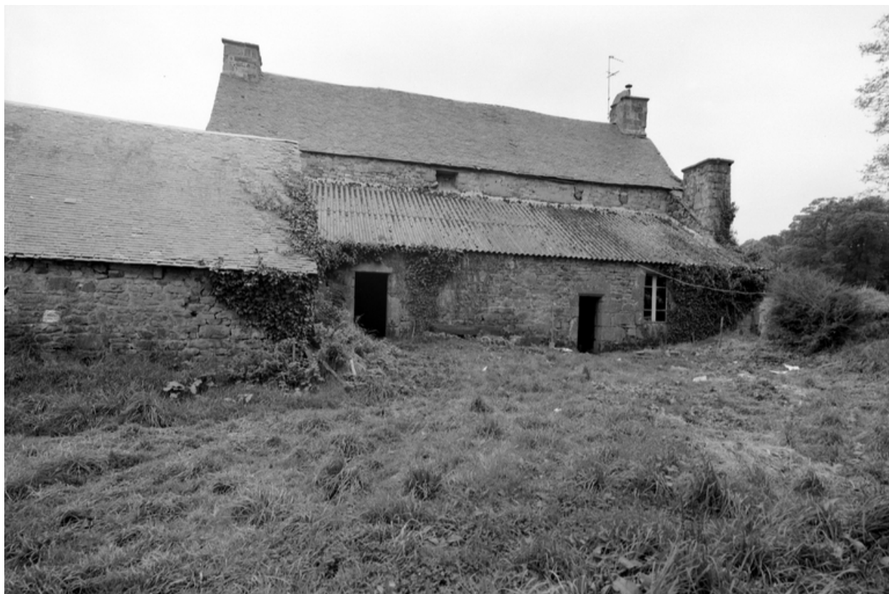
Façade nord du logis
