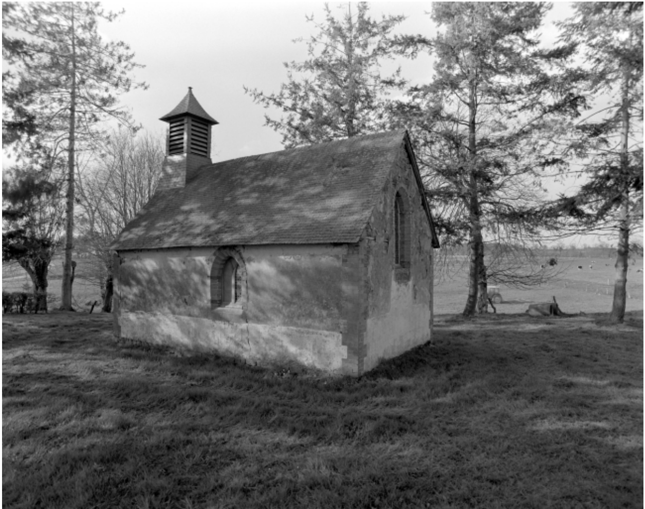
Elévation Sud : vue générale
