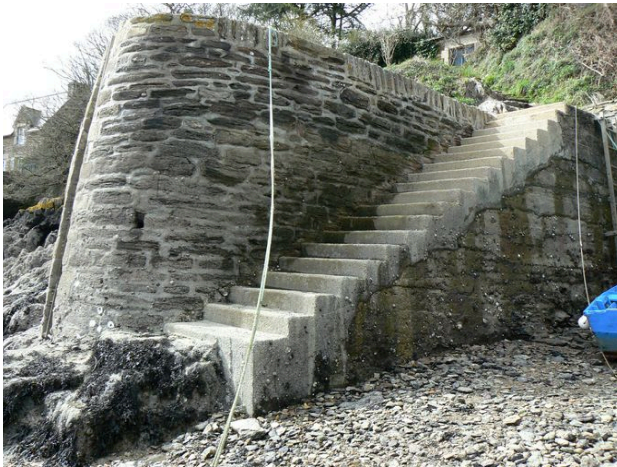
Escalier du môle 'Joseph Tonnerre' permettant l'accès à l'estran
