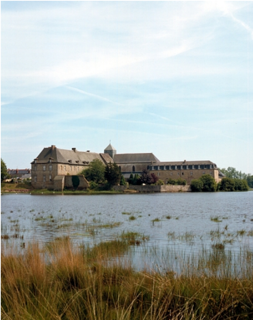
Vue partielle nord-ouest
