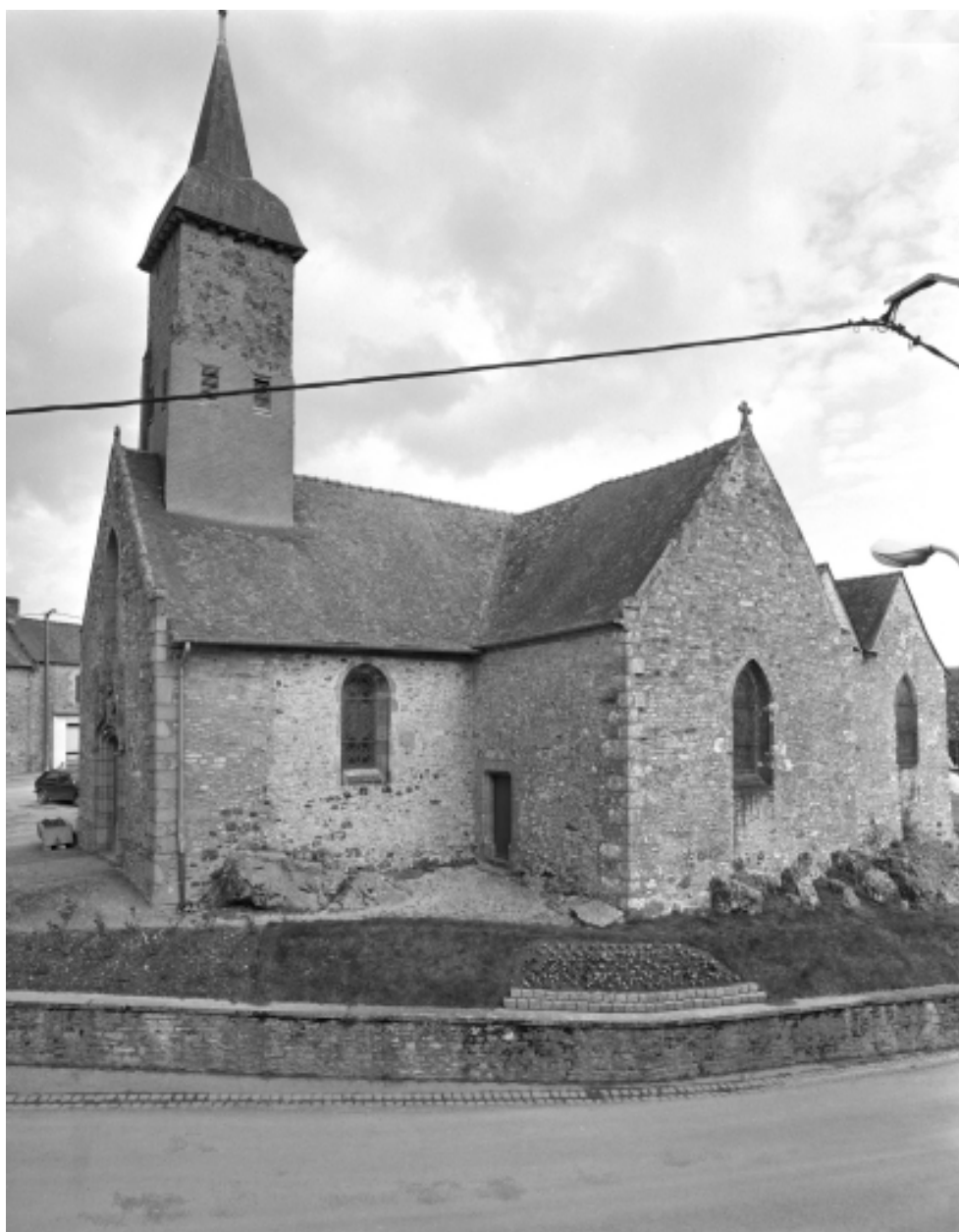
Façade latérale sud
