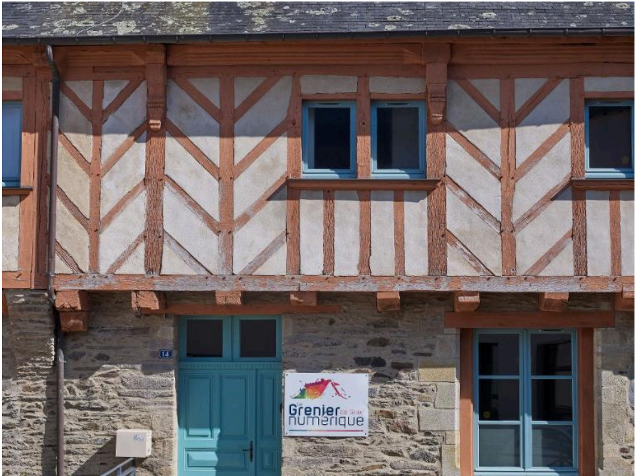
Vue rapprochée du pan de bois du premier étage.
