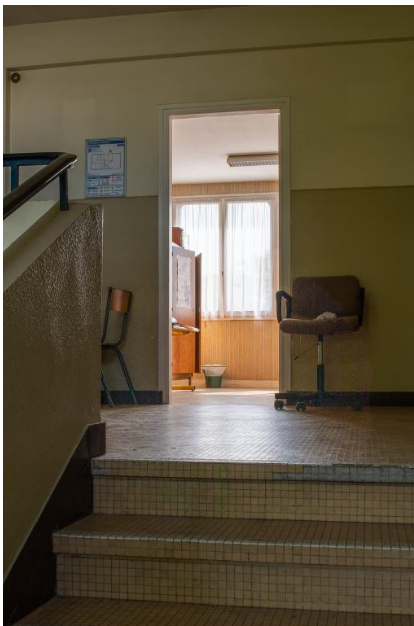
Escalier et palier du 1er étage.
