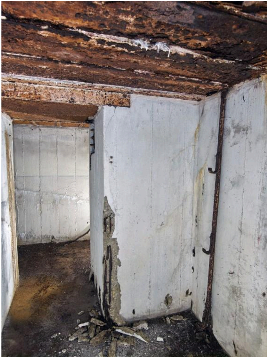
Vue du logement des soldats de la chambre de combat sud-ouest : fixation murale et crochets de suspension pour trois couchettes tubulaires
