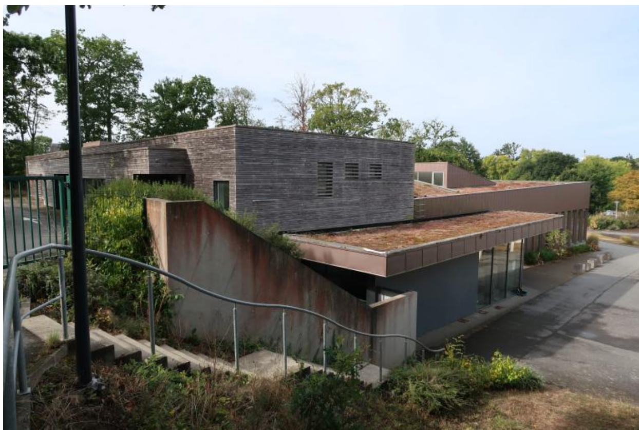
Vue d'ensemble du service de restauration prise du nord-est.
